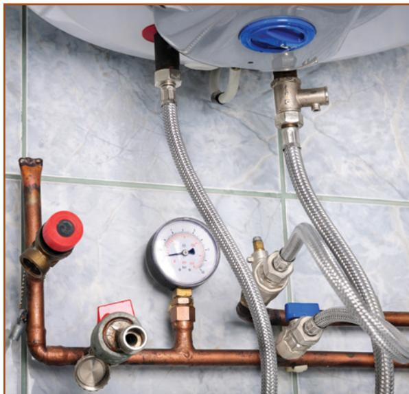
Dans le système de distribution, la clé pour réduire la consommation d'eau et d'énergie est de réduire le temps nécessaire pour acheminer l'eau chaude du chauffe-eau aux appareils et aux électroménagers. L'isolation des canalisations d'eau chaude réduit les pertes de chaleur dans le système de distribution (la chute de température dans une canalisation non isolée de 30,5 m (100 pi) est d'environ 2,8 °C ou 5 °F).
