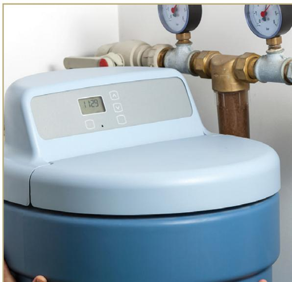
Les adoucisseurs d'eau sont populaires dans les régions où l'eau est très dure. La plupart sont de type « échangeur d'ions », c'est-à-dire qu'ils substituent les ions calcium et magnésium présents dans l'eau dure par des ions sodium. La résine échangeuse d'ions de ces appareils doit être rechargée d'ions pour continuer d'adoucir l'eau. Pour ce faire, elle est rincée avec une
